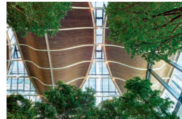
The cross-section of the skylights is shaped like an arch, and the ground plan is uneven. Der Querschnitt der Lichtdächer ist bogenförmig und der Grundriss ungleichmäßig.
